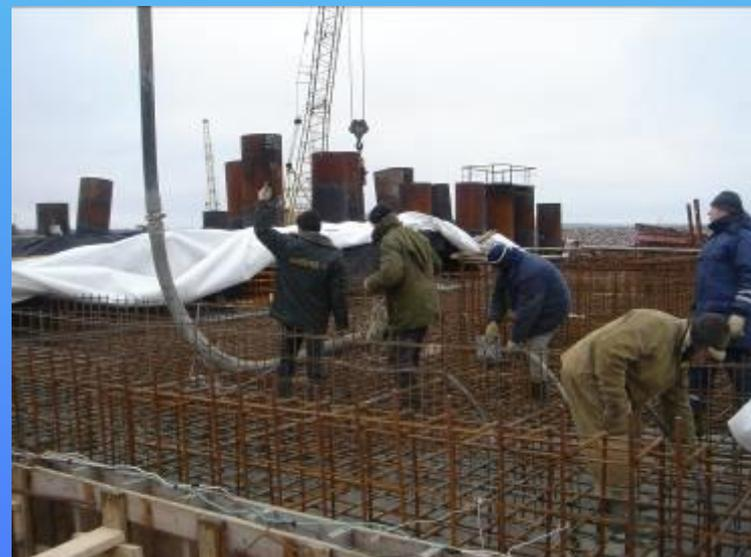
Дальность перекачивания бетонной смеси 250÷350м
