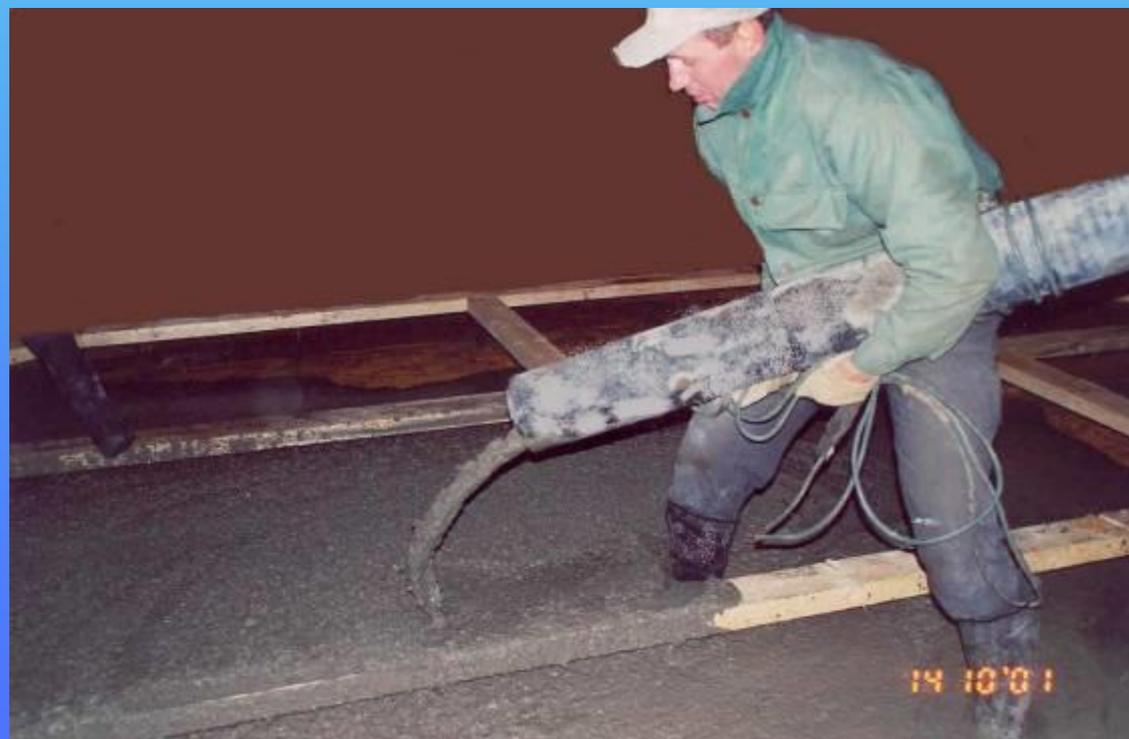
СУБС позволяет производить укладку бетона без виброуплотнения
