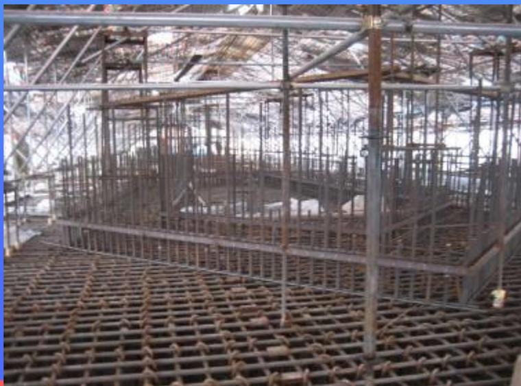
Бетонирование с применением СУБС ростверка опоры моста через бухту Золотой Рог.
