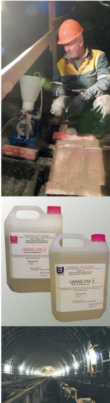
Высокая эластичность составов **ЦМИД-СМ** позволяет восстанавливать деформационные и холодные швы, выполнять работы на конструкциях и сооружениях, которые находятся под действием динамических нагрузок.
