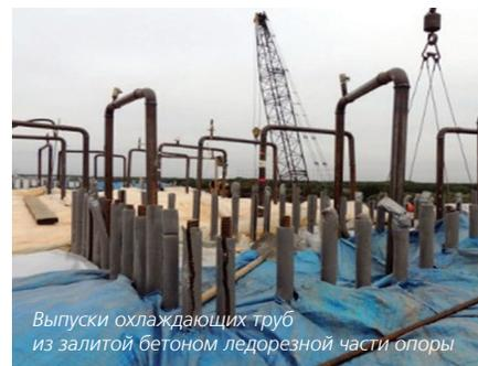
Выпуски охлаждающих труб из залитой бетоном ледорезной части опоры
