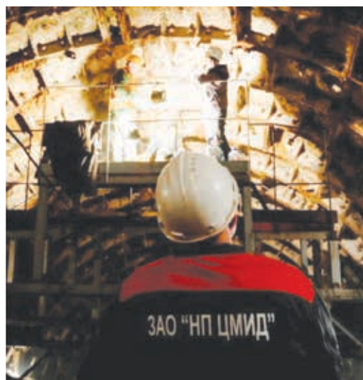
Рис. 1. Производство работ по устранению фильтрации воды через швы между чугунными тубингами наклонного хода. Станция метрополитена «Пушкинская» (г. Санкт-Петербург), 2014 год
