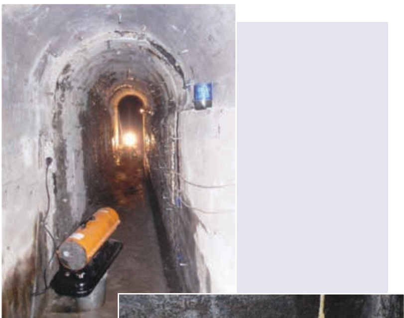
Рис. 7. Улитка галереи нижней головы шлюза №9 ББК. Остановка фильтрующей течи полиуретановым материалом ЦМИД-ПС 1
