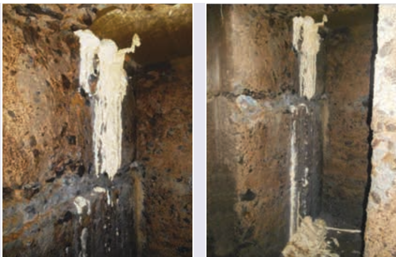
Рис. 7. Улитка галереи нижней головы шлюза №9 ББК. Остановка фильтрующей течи полиуретановым материалом ЦМИД-ПС 1
