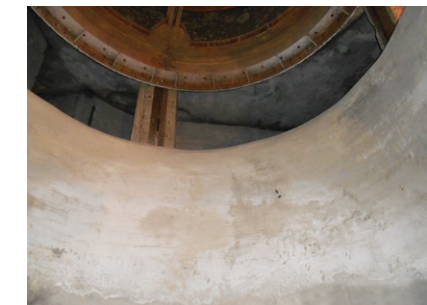
Рис. 4. Шлюз №9. Нижняя голова. Галерея Западная сторона. После выполнения ремонтных работ
