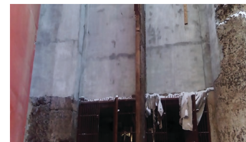
Рис. 5. Шлюз №9. Нижняя голова. Восточная сторона. Шкафная ниша
