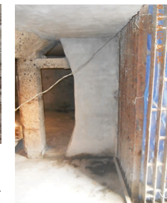
Рис. 6. Шлюз №9. Нижняя голова. Западная сторона. Улитка
