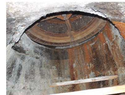
Рис. 3. Шлюз №9 Нижняя голова. Галерея Западная сторона. До выполнения ремонтных работ
