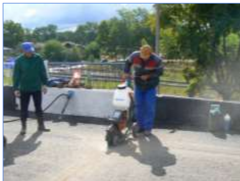
Штрабление и зачистка поверхности
