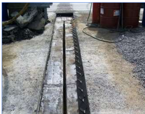
Штрабление и зачистка поверхности
