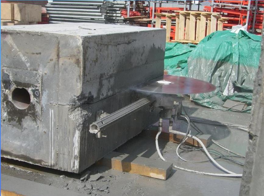
Внешний вид бетона после распиловки
