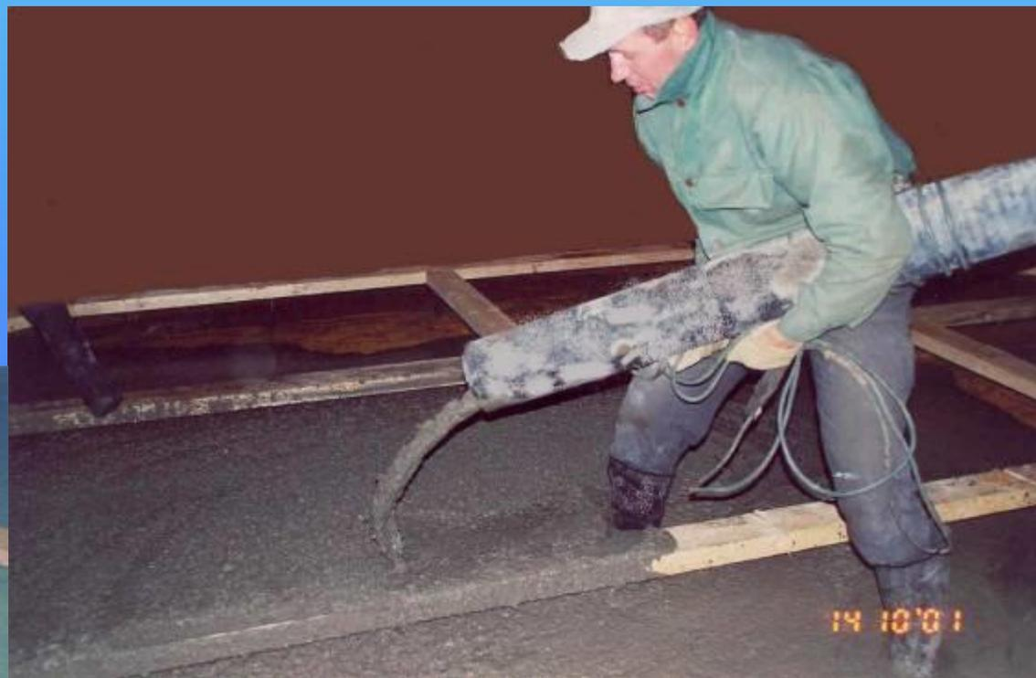
СУБС позволяет производить укладку бетона без виброуплотнения
