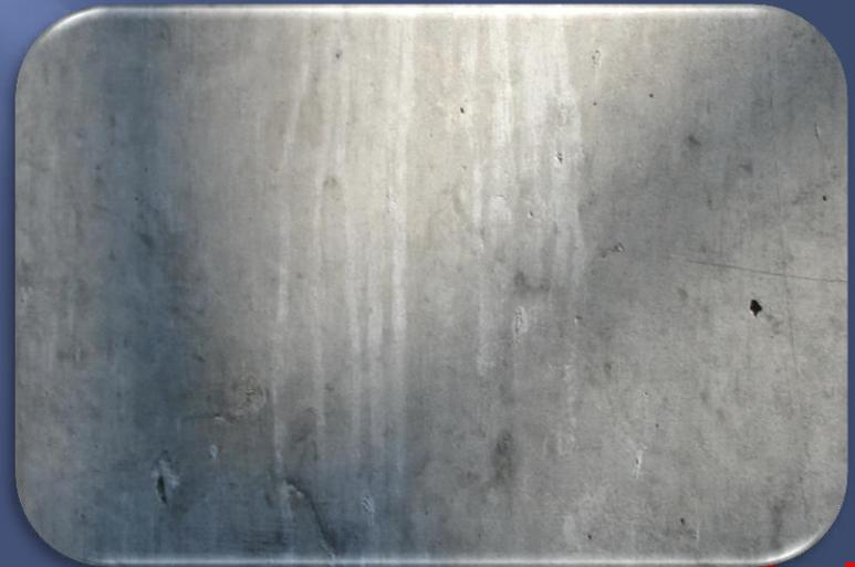
Типовые дефекты бетонирования традиционными бетонами
